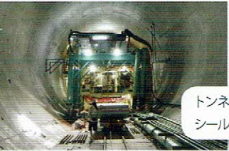
発進前に工場で仮組し たシールドマシン
