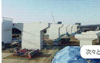
基盤整備を終え橋脚の施工を進めている様子
