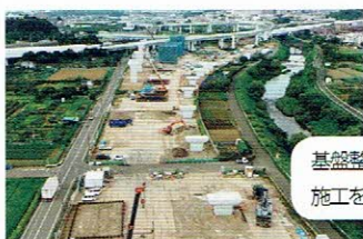
橋脚の土台部分の建設に着手
