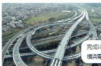
東名高速道路との接続部での架設工事
