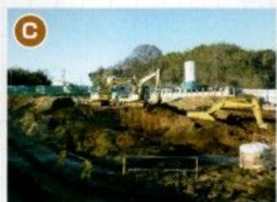
周囲に土留壁を設置した後、内部をショベルで掘削しています。
