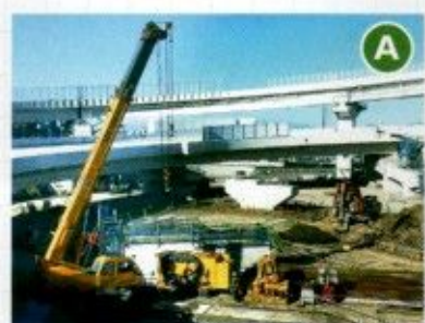
港北JCT内で北西線・北線と川向線とをつなぐ道路の橋脚をつくっています。
