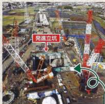
北八朔町 発進立坑(地上部)
