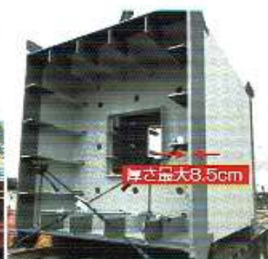
鋼製橋脚の柱の断面
