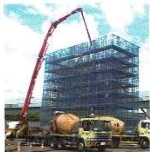
コンクリート打設
