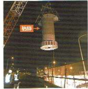
クレーンによる組立て
