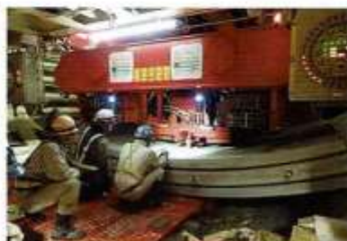
トンネル内での組立て作業の様子
