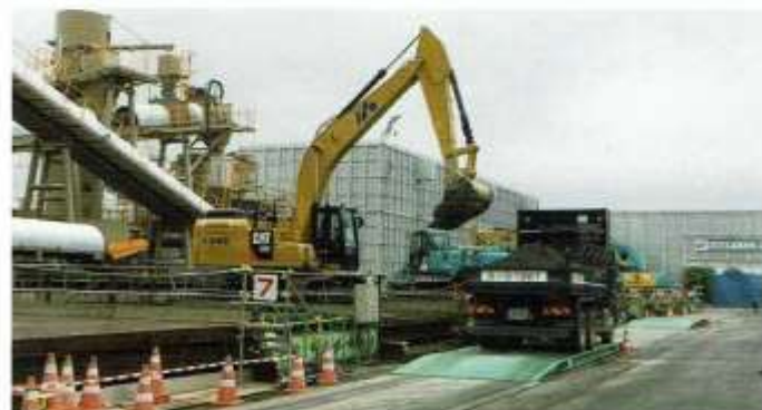
土がトラックに積まれる様子
