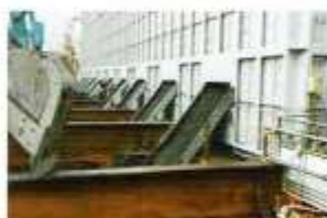
分離された土が排出される様子
