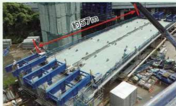
横浜青葉IC・JCT(仮称)に架設した橋桁(10月11日架設) 長さ: 約57m 幅: 14.2m 高さ(桁高): 約2.4m 重さ: 約550t
