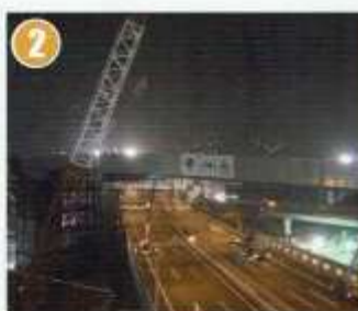
平成29年10月11日架設工事
