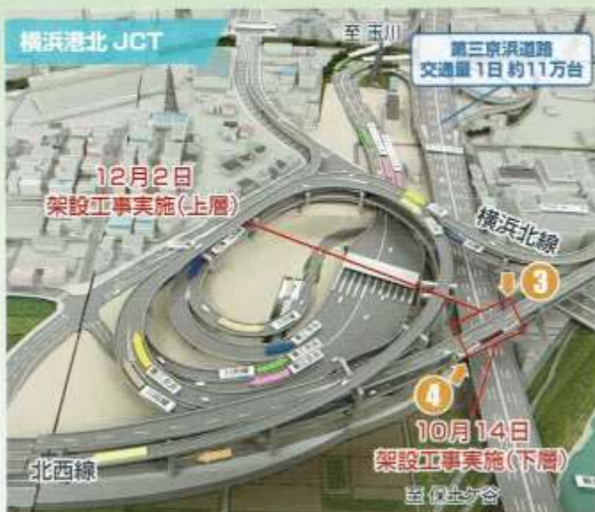
横浜港北 JCT 完成模型
