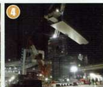
平成29年12月2日架設工事
