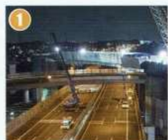
平成29年10月3日架設工事
