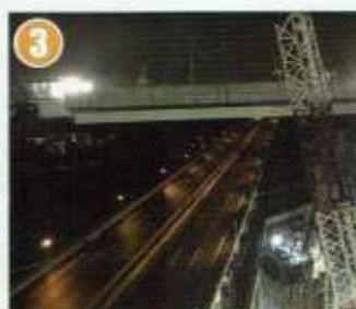
平成29年10月14日架設工事
