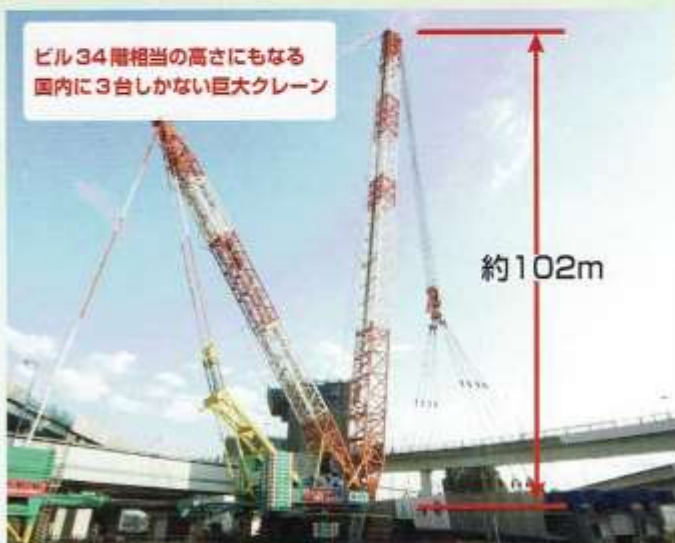
1600t吊クローラクレーン
