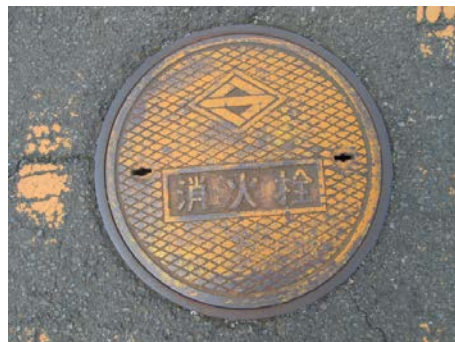
【新型消火栓】 *蓋のデザインに違いがあります。 【旧型消火栓】
